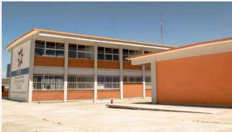
Instalaciones Villa de Reyes
