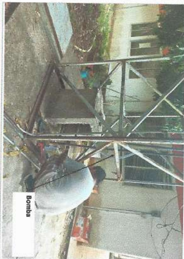
F1: Sustitución de sistema de bombeo
