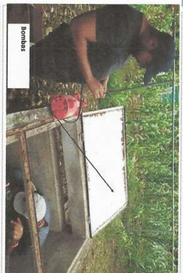
F5: Sustitucion de sistema de bombeo.
